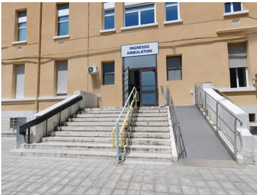
Figura 24. Indicazioni ingresso ambulatori e rampa di accesso dedicata.
